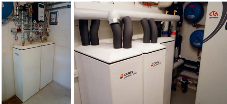
Abbildung 15: Zwei Installationsbeispiele von Pilotanlagen, umgesetzt in Q3 2024: Warmwasser- und Pufferspeicher (links) sowie drei Pufferspeicher (rechts).
